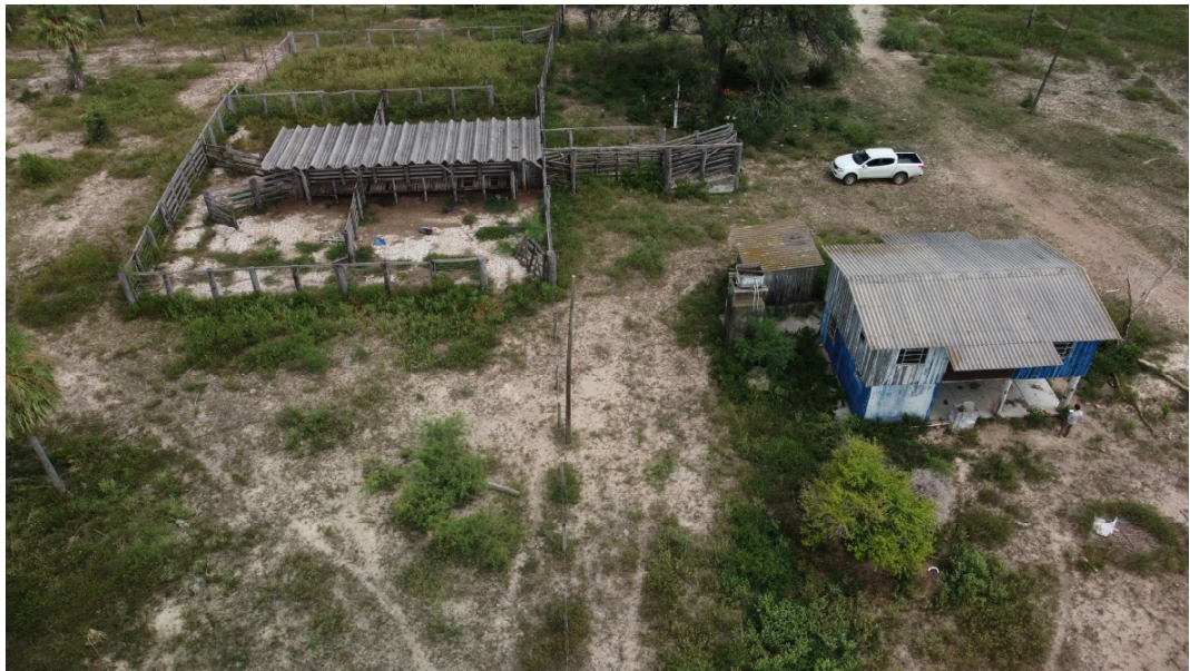
Foto da pequena casa e do mangueiro existentes no imóvel de Matrícula nº 2.444, em estado de abandono.
