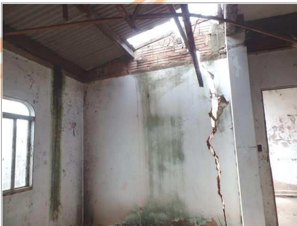
Cômodo de acesso a residência.
